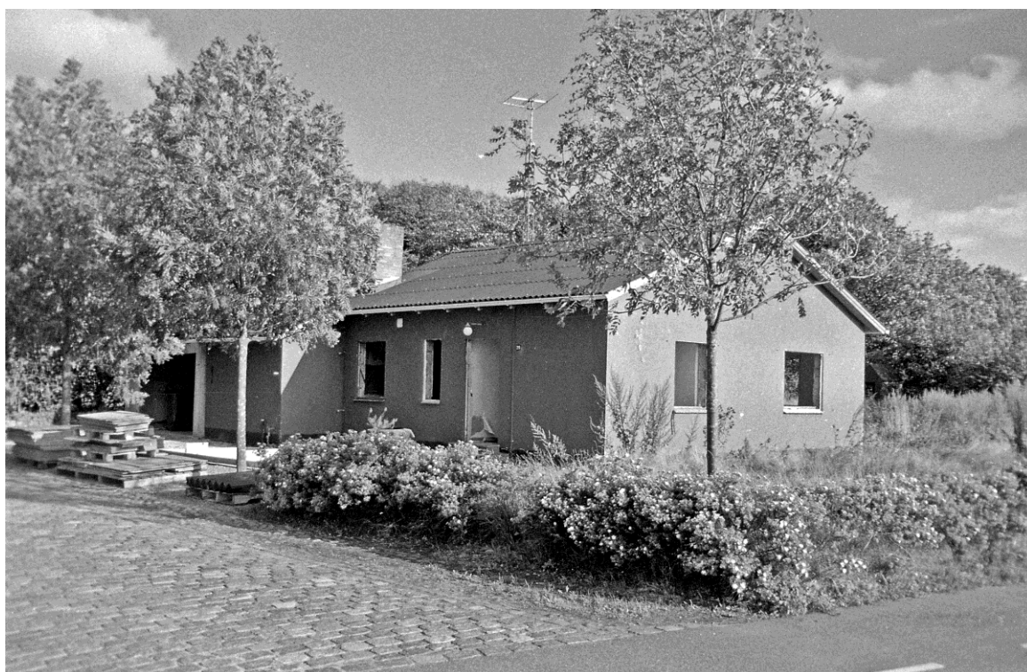
Vardevej 29 under nedrivning 2006.
