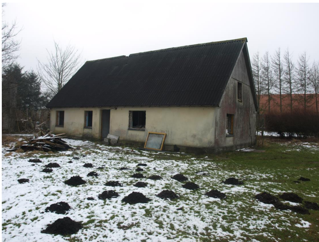
Vardevej 7 Hauge under nedrivning i 2013.
