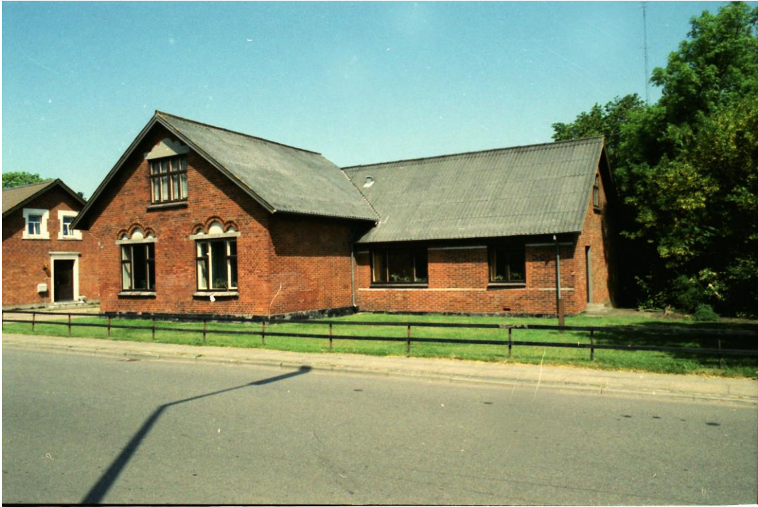
Storegade 57 Tistrup. Nedrevet i 2011. På grunden er opført 2 seniorboliger.
