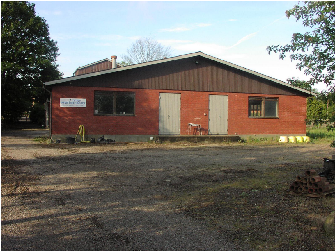
Storegade 59 Værkstedbygning ud mod Bøgevej. Nedrevet i 2004 På grunden opført seniorboliger Bøgevej 14 .
