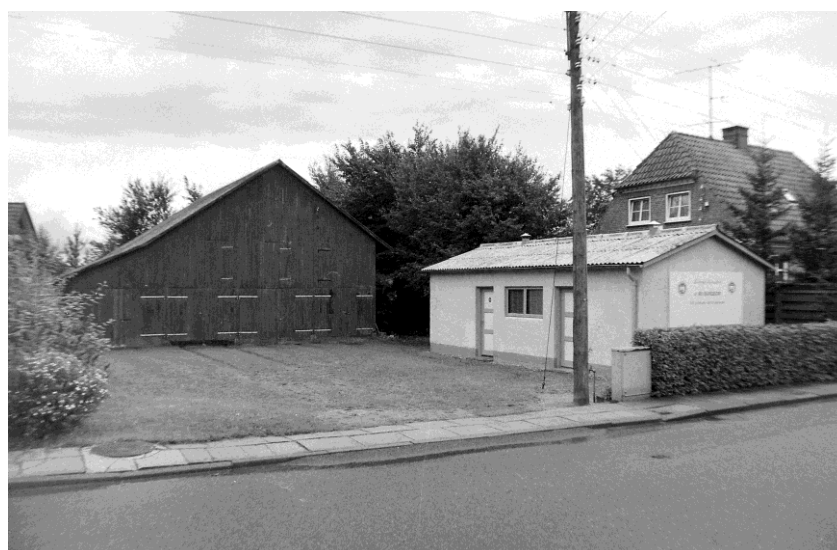
Søndergade 26. Værkstedbygning (Kronborg Jensen) og frysehus.
