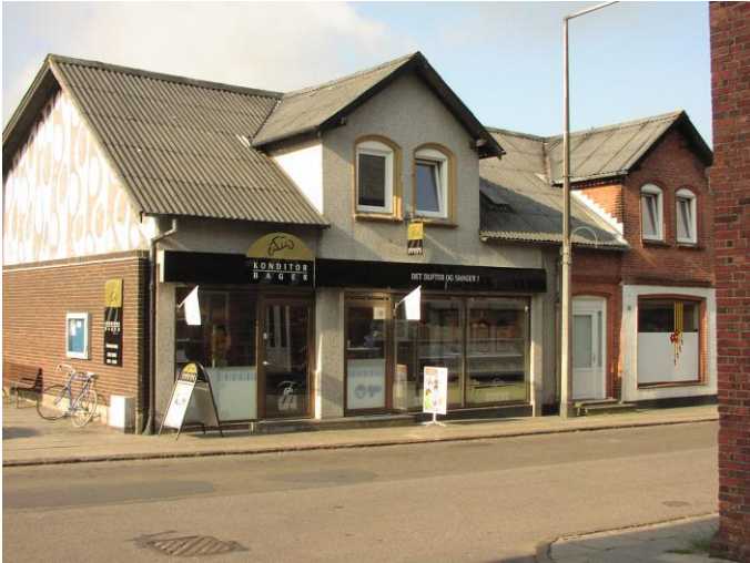
Storegade 18, bagerforretning 2004. Bygningsdelen til venstre er den tidligere Storegade 20
