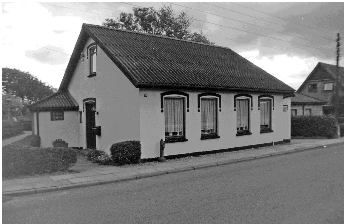
Søndergade 36. Nedrevet i forbindelse med udvidelse af Tistrup Plejehjem først i 1990'erne
